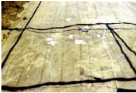
شكل رقم ١٠: في حالة حدوث ثقبوب بالبلاستيك لأي سبب كان، يجب إغلاقها بأشرطة لاصقة
